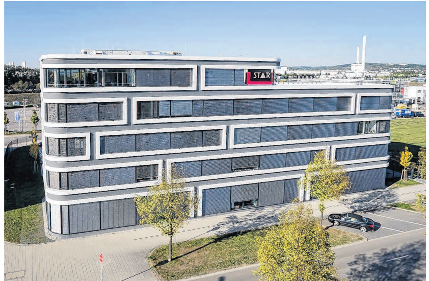
Die Star Deutschland GmbH wird ihren Neubau um Büros und ein Rechenzentrum erweitern.
